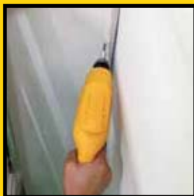
2 Colocación de tornillos en marcos de ventanas y perforación de agujeros en marcos de madera. Taladro de Rotación STDR5510
