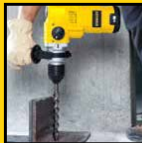
4 Perforación de agujeros en concreto para colocación de barras de refuerzo y pavimentación de piso de madera. Rotomartillo SDS Plus STHR1232K
