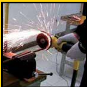
1 Corte de barras de refuerzo, esmerilado de líneas de soldadura. Esmeriladora Angular STGS6115/7115/8115
